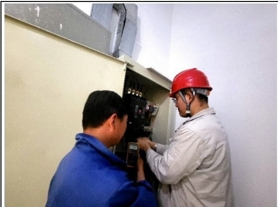
开展施工用电专项检查
