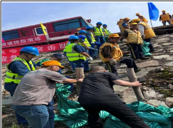
开展铁路专线路堤滑坡安全演练
