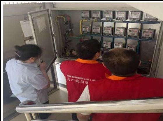
开展职工宿舍消防及用电安全检查
